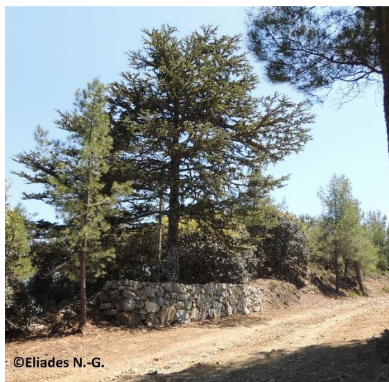
Εικόνα 3.7: Δημιουργία ατομικής ξερολιθιάς για την αποτροπή διάβρωσης του εδάφους, στην περιοχή του ριζικού συστήματος ώριμου ατόμου C. brevifolia .
