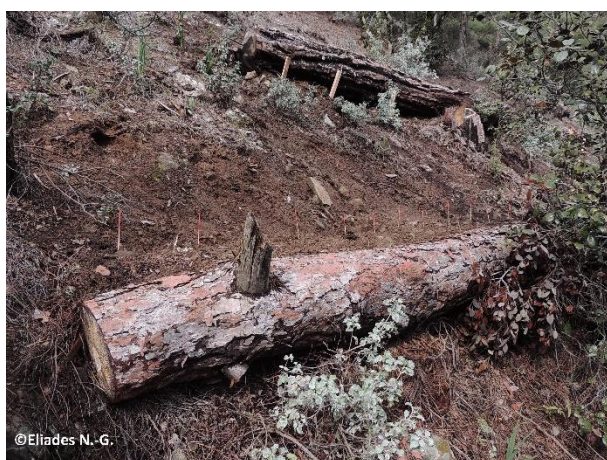
Εικόνα 3.11: Εργασίες εγκατάστασης κορμοδεμάτων για την αποτροπή απομάκρυνσης επιφανειακού εδάφους σε θέσεις εντός του οικοτόπου
