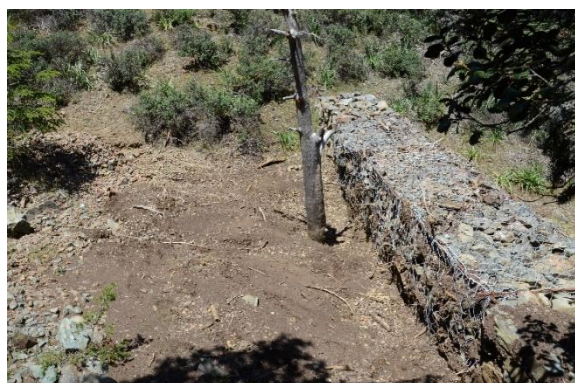
(α) Θέσεις εγκατάστασης και «λειτουργίας» gabions εντός της κοίτης του ρέματος Ηρκάς Στερατζιάς
