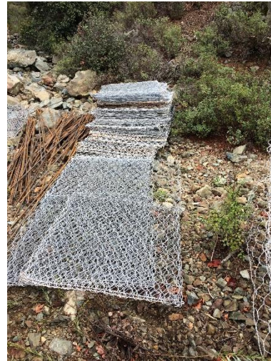
Εικόνα 3.1: Φωτογραφικό υλικό από την εγκατάσταση των gabions εντός της κοίτης του ρέματος Ηρκάς Στερατζιάς, το οποίο διέρχεται της Κουλάδας των Κέδρων.
