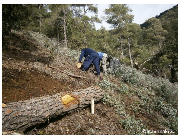
Εικόνα 3.11: Εργασίες εγκατάστασης κορμοδεμάτων για την αποτροπή απομάκρυνσης επιφανειακού εδάφους σε θέσεις εντός του οικοτόπου
